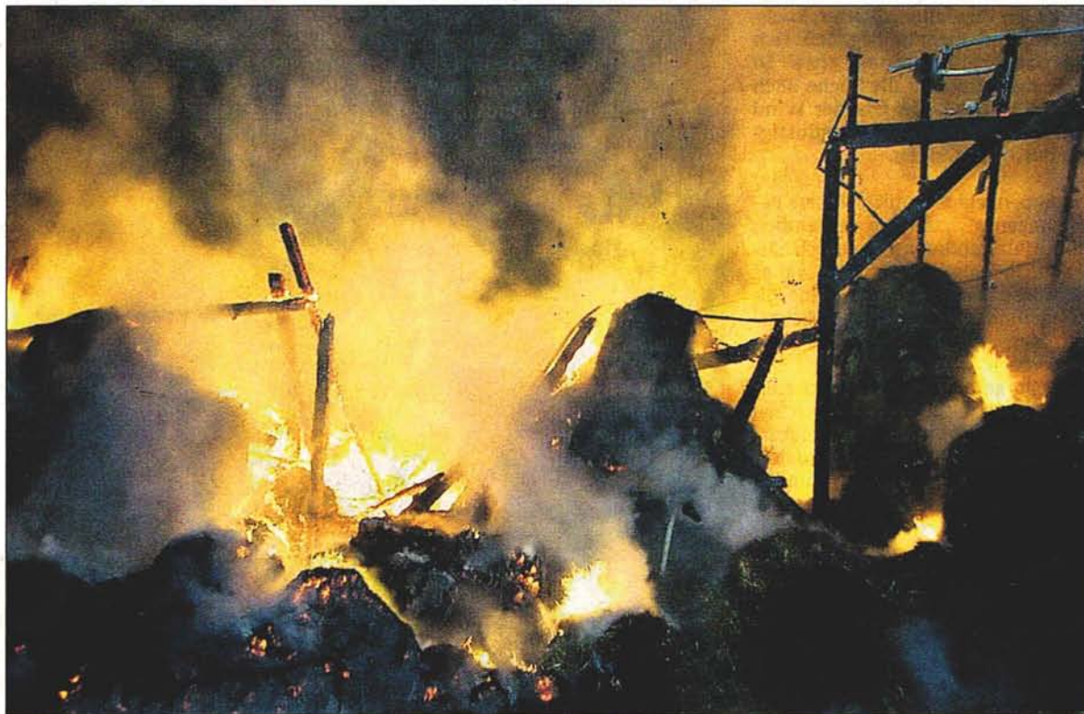
Die Scheune des Reitstalls auf dem Fröhnerhof wurde durch die Flammen völlig vernichtet.
